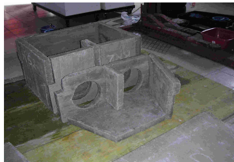
Y und Kessel ohne Deckel (Y teilweise ohne Rückteil und Seitenwand) (Zwischen Y und Kessel haben wir 1m /20cm Betonrohre verlegt)
