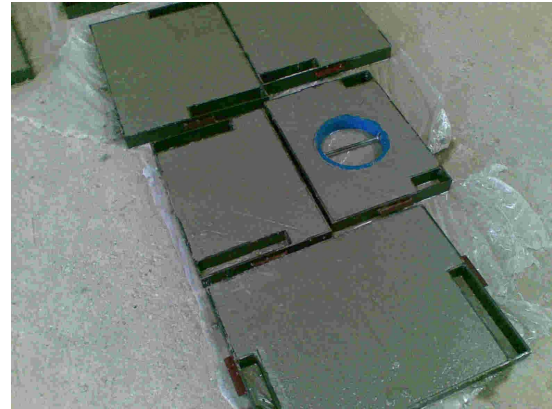
Schalung Y mit Beton
